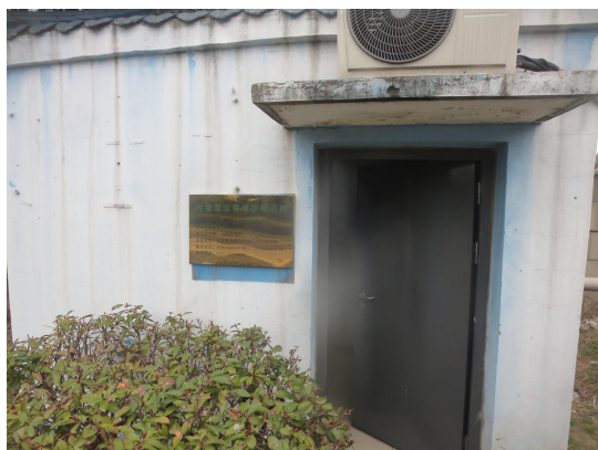
图 4.2-2 新浦化学污水排口在线监测房
