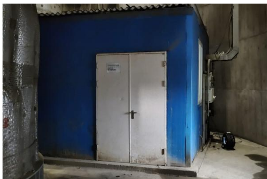
废气排口在线监测房
