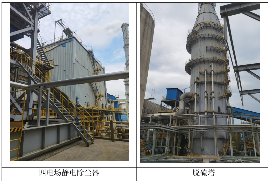
图 4.1-1 废气处理装置
