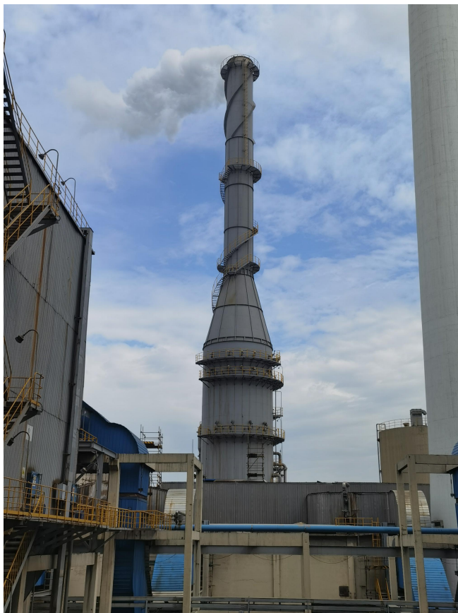
图 4.2-1 本项目锅炉烟气排放烟囱
