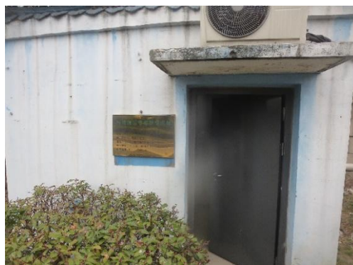
污水总排口在线监测房
